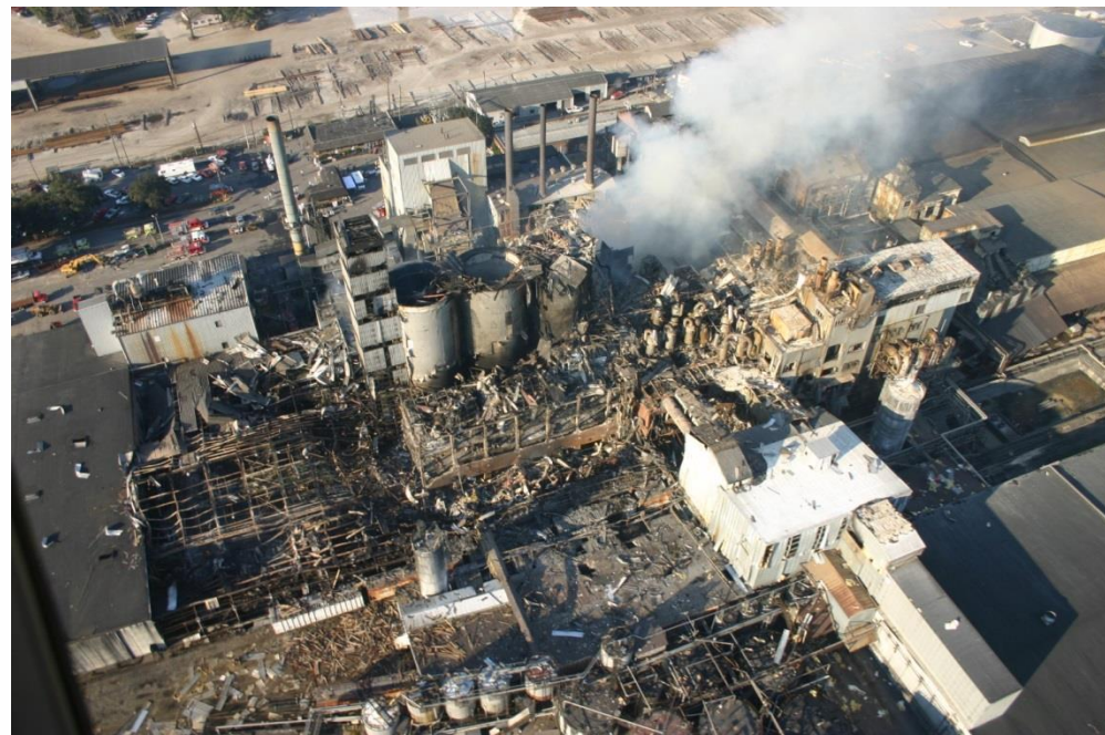
Βιομηχανία ζάχαρης μετά από έκρηξη σκόνης
